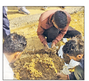
चरखी दादरी। सड़क निर्माण में लगी सामग्री का सैंपल लेते अधिकारी।
